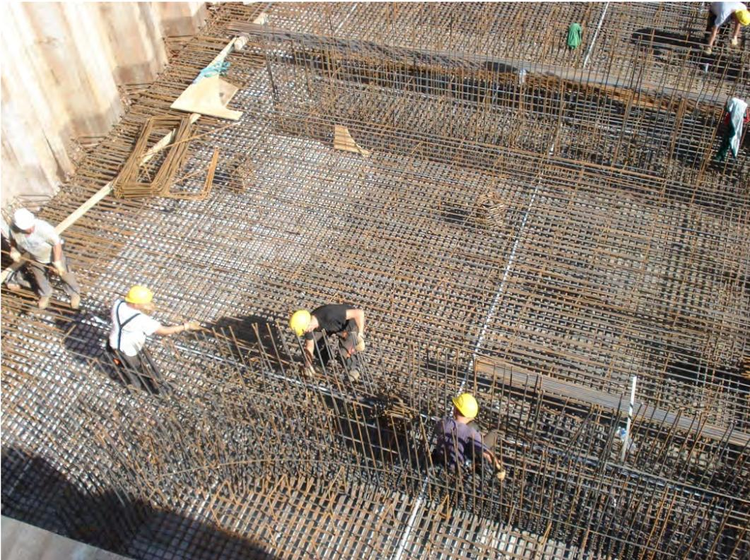
Nachdem der Konstruktionsbeton seine Anfangsfestigkeit erreicht hatte, wurde mit den Schal- und Bewehrungsarbeiten der Wände begonnen. Die aufgehenden Wände sind 12 Meter hoch. Diese wurden in mehreren Teilabschnitten bewehrt, verschalt und betoniert.
