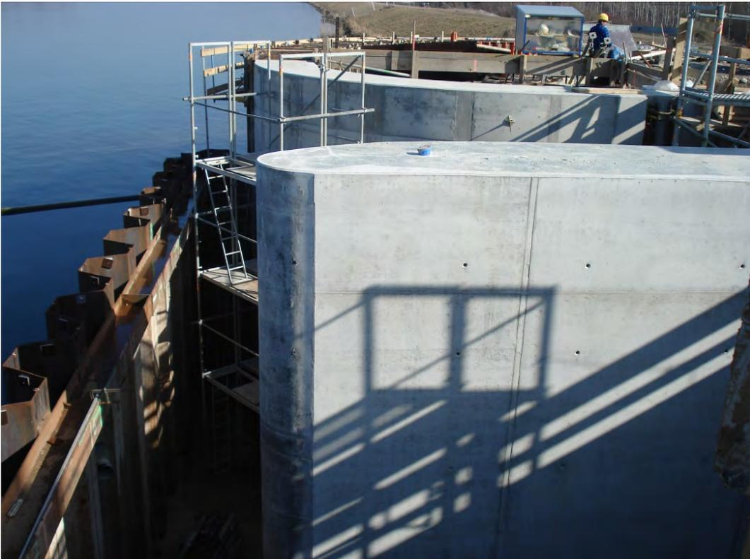
Derzeit erfolgt die Montage der Einbauteile des Stahlwasserbaus (Führungsschienen, Verschlüsse aus Stahl). Durch den umschließenden Spundwandkasten wird die Sicherheit des Rheinseitendammes jederzeit sichergestellt.
