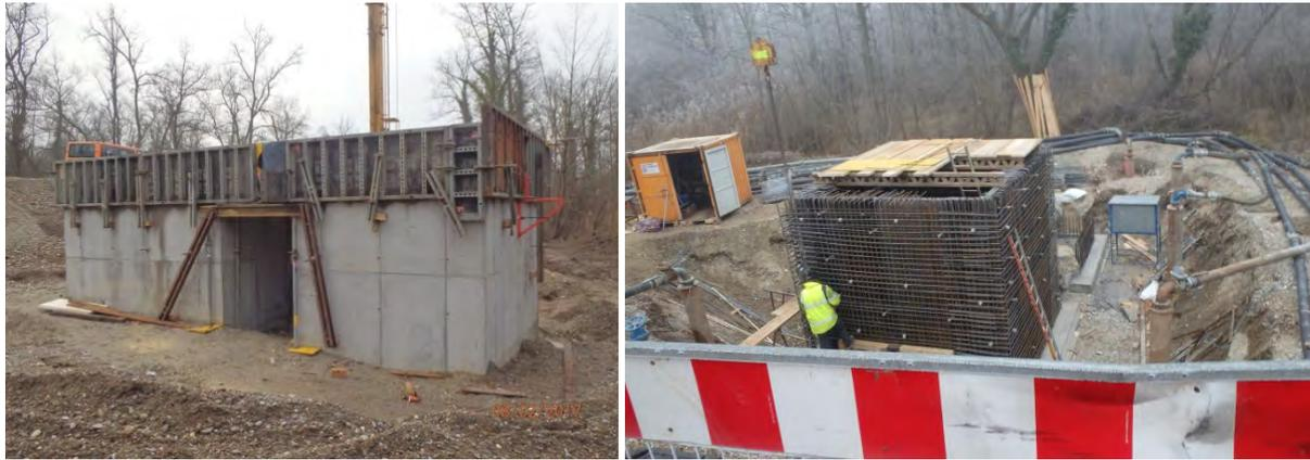
Mitte Februar soll nun mit dem Bau des Durchlassbauwerkes K1 auf Gemarkung Kappel begonnen werden. Der Damm wurde im Bauwerksbereich bereits abgetragen. Nun werden als nächstes die Spundwände als Gründung des Bauwerkes eingerammt.
