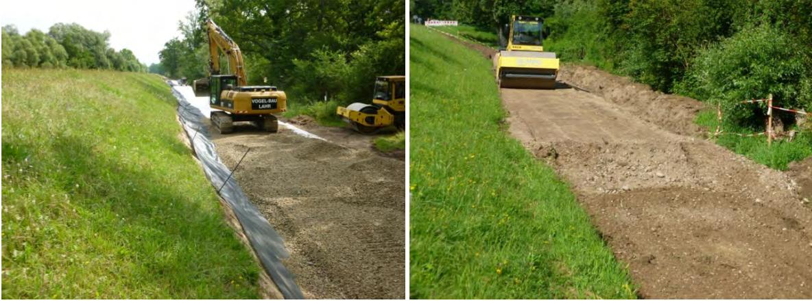
Im Herbst 2016 wurde dann mit dem Bau der neuen Schächte für die bestehende Druckleitung des Abwasserzweckverbandes begonnen. Zuerst musste eine Grundwasserabsenkung durchgeführt werden, damit die Baugrube trocken ist. Danach mussten die Druckrohrleitungen gesichert werden, da der Betrieb der Druckrohrleitungen auch während der Bauzeit gewährleistet werden musste.
