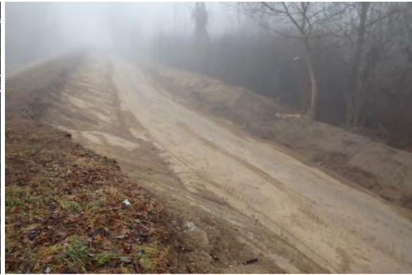
Derzeit wird auf der Luftseite der bestehende Weg verbreitert und auf der Wasserseite wird die neue Dammböschung (eine sogenannte Berme) profiliert und ein durchgehender Dammverteidigungsweg auf der Luftseite hergestellt.
