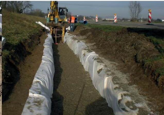
Teilgefüllter Leitungsgraben mit Verbau
