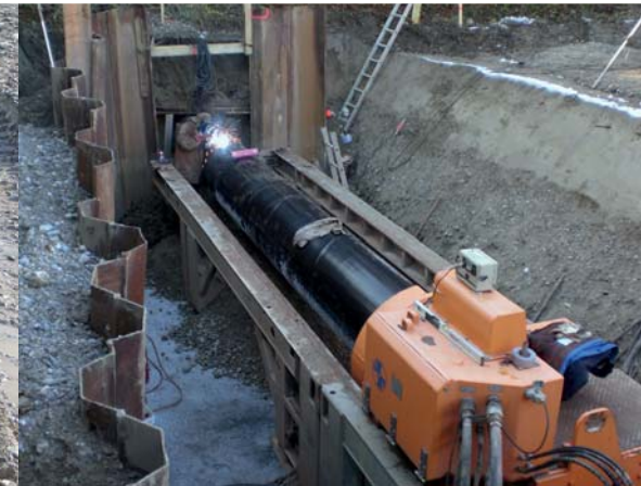
Unterirdische Durchpressung mit hydraulischem Rohrvortrieb
