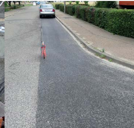
Verschlüssener Leitungsgraben im innerstädtischen Bereich
