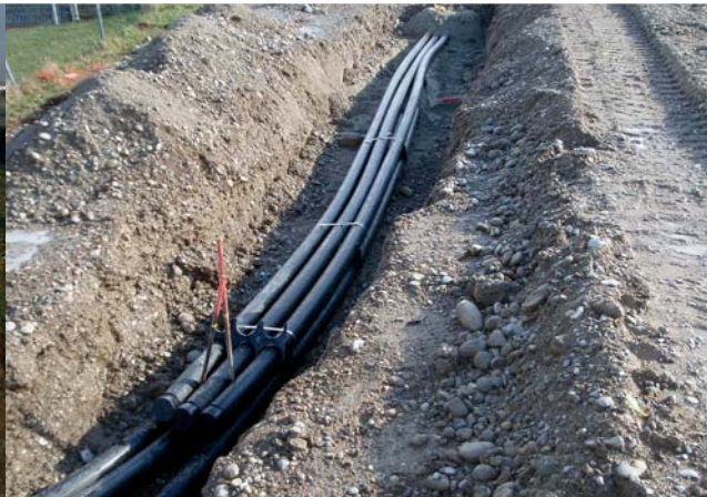
Verlegte Leerrohre für Strom- und Steuerleitungen
