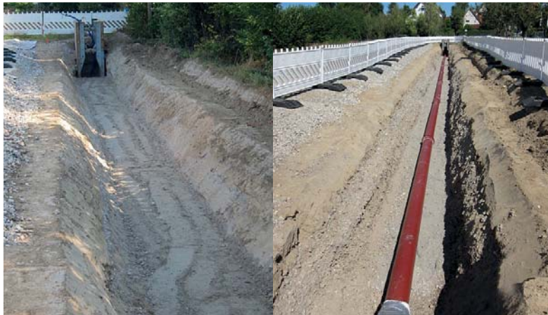
Aushub des Leitungsgrabens mit Verbau
