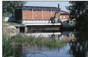
Das Schöpfwerk am Philippsburger Altrhein wird durch den Einbau von zwei zusätzlichen Pumpen erweitert.
