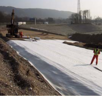
Einbau der Dichtungsschicht
