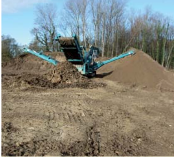
Siebanlage für Oberboden
