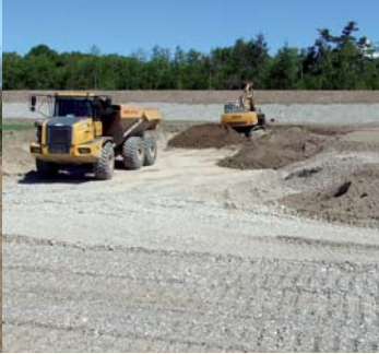
Einbau der Rekultivierungsschicht
