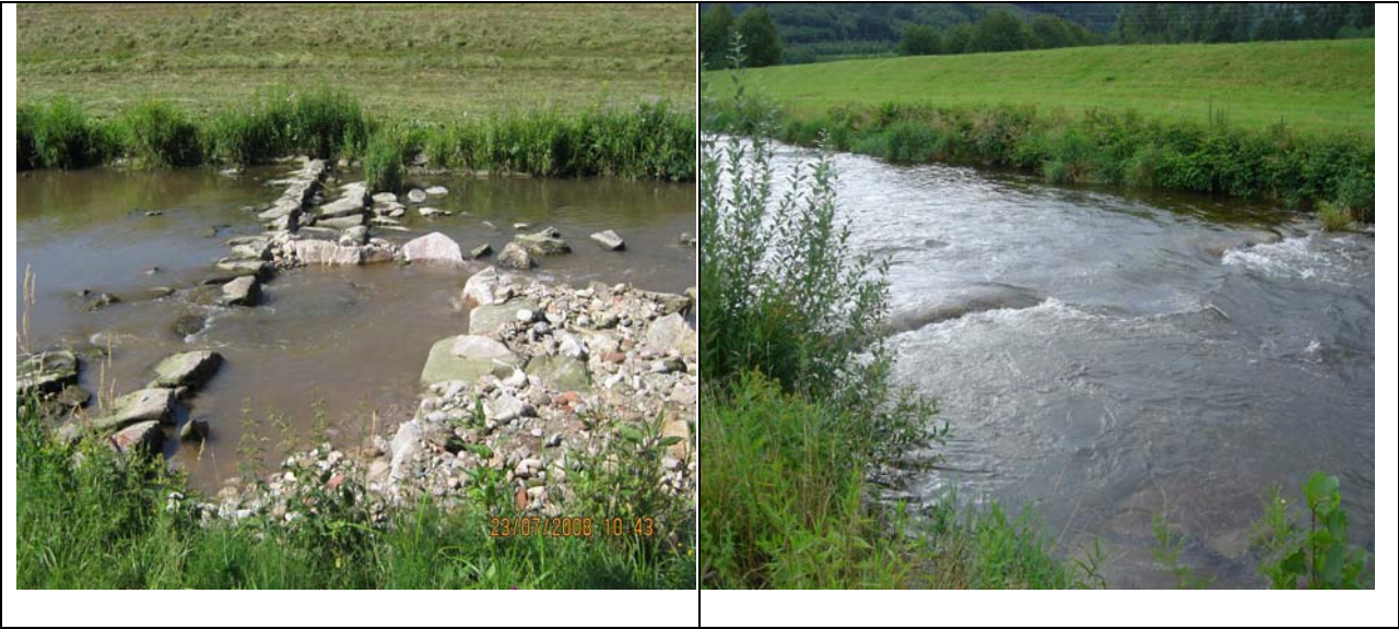
Abbildung 5/6 Sohlschwellen nach erfolgtem Umbau
