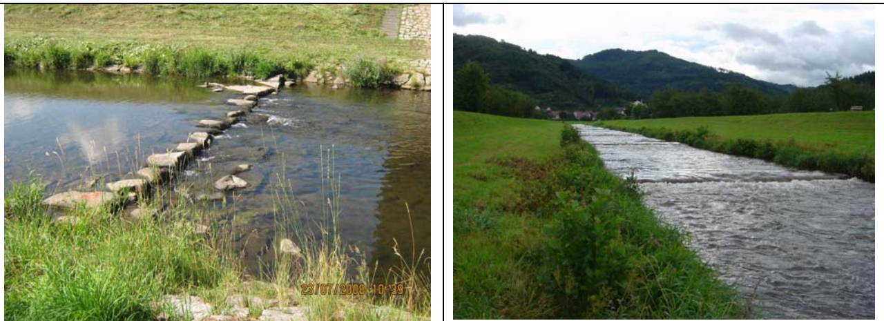
Abbildung 3/4 Sohlswellen vor dem Umbau
