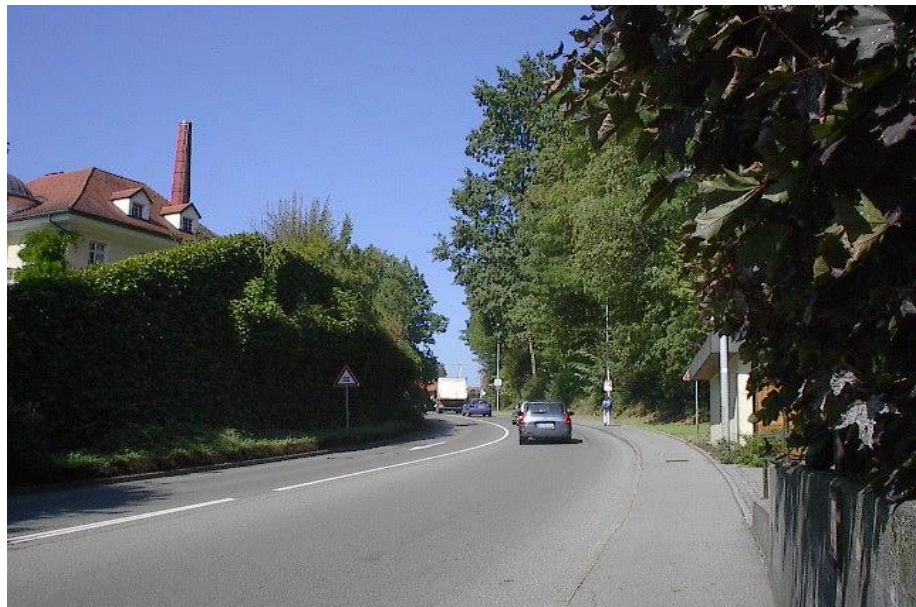
Abb. 2: Bestehende B 32 im Bereich Buchweg (Blick vom Bauende nach Nordwesten). Die begrünte Stützwand auf der linken Straßenseite sollte Vorbild für die geplanten Stützwände sein. Auf der rechten Seite ist der Gehölzbewuchs am Stadtpark zu sehen, der durch die Baumaßnahme beansprucht wird (Datum 2006)
