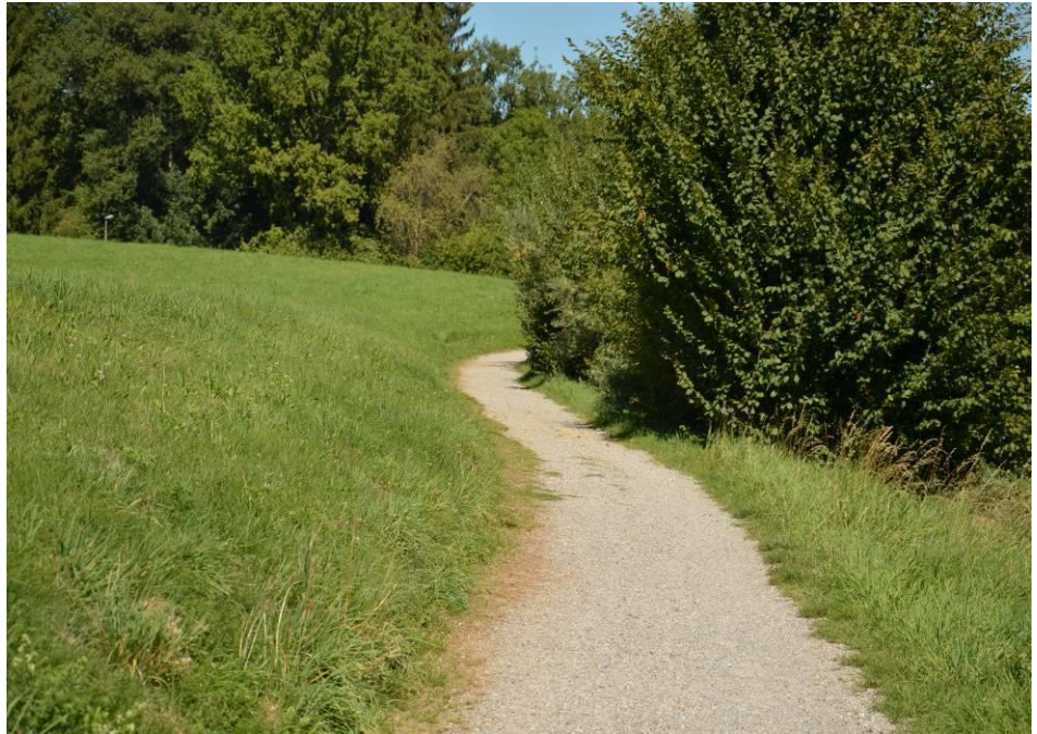
Abb. 9: Umleitung zur Kleingartenanlage. Der bestehende 2 m breite Weg wird in diesem Abschnitt wiesenseitig um 1,5 m verbreitert. Die Hecke auf der rechten Seite auf der Böschung bleibt erhalten.
