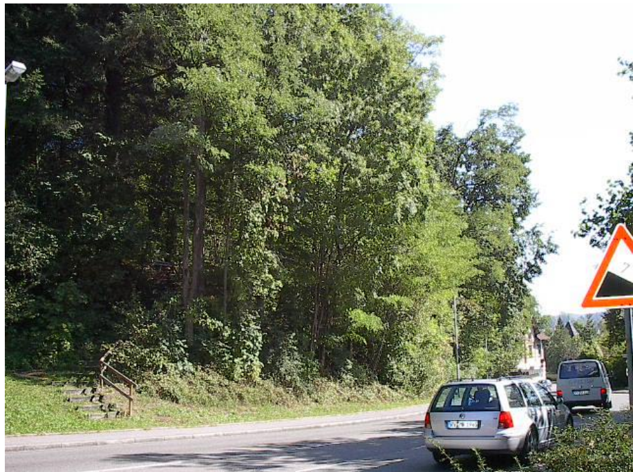
Abb. 4: Blick auf den Westrand des Stadtparkes, der von der B 32 neu auf rd. 70 m Länge beansprucht wird : die B 32 neu wird hier tiefergelegt und bis zu 20 m in Richtung Park verschoben. Der Zugang links im Bild entfällt (Datum 2006)
