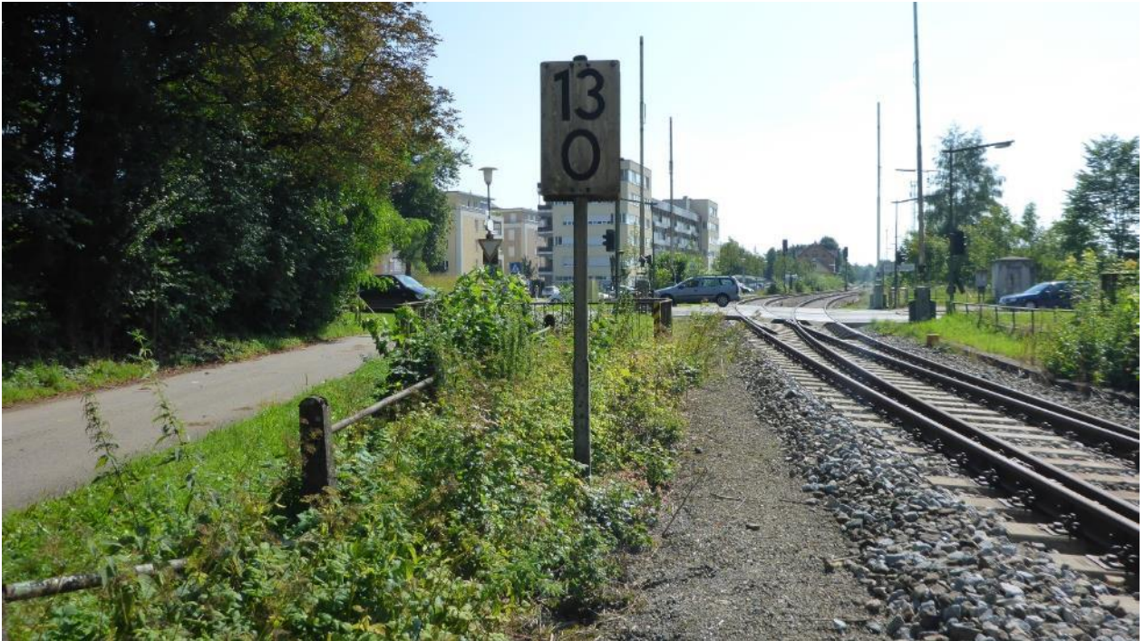
Abbildung 5: Bahnlinie, Bahnübergang im Hintergrund (südlich) und Zufahrt Fronwiesen. 02.08.2017.
