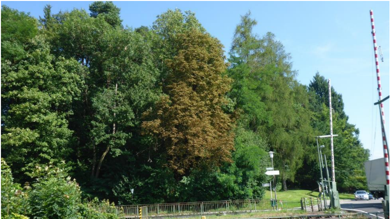
Abbildung 7: Stadtwald-Bereich an der Ravensburger Straße und Teil Bahnübergang. 02.08.2017.
