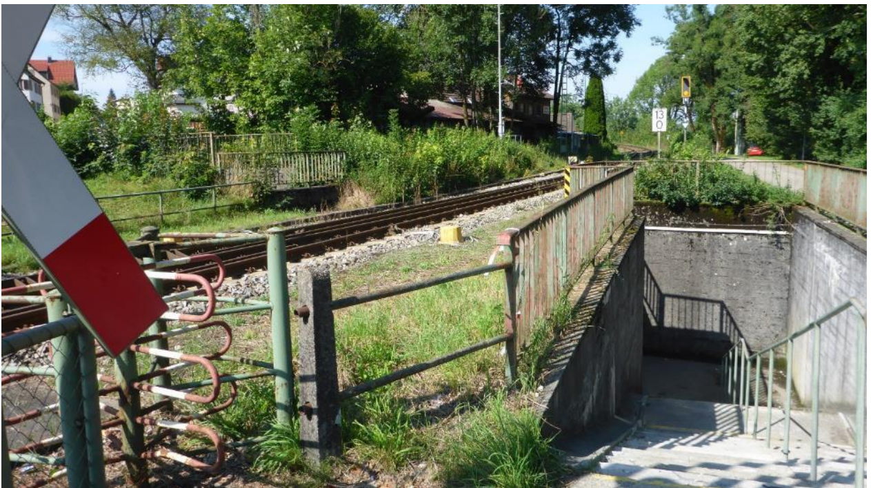
Abbildung 6: Unterführung und Blick Richtung Norden. 02.08.2017.
