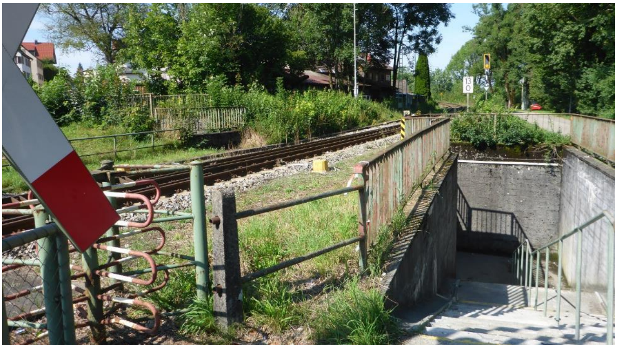
Abbildung 6: Unterführung und Blick Richtung Norden. 02.08.2017.
