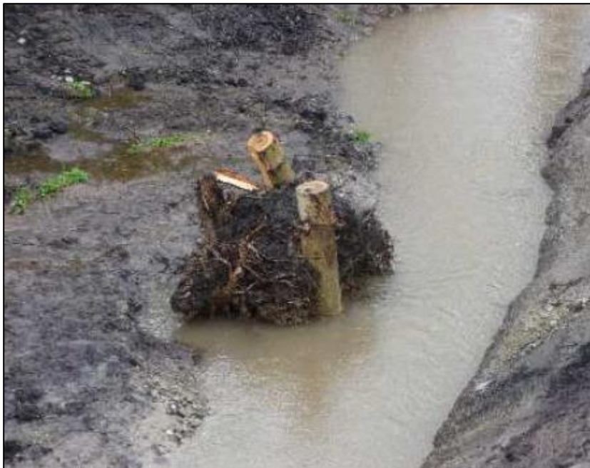
Abb 1.: Einbringen von Wurzelstöcken (hier mit Eichenpfählen gesichert), Foto: A.Woll,
