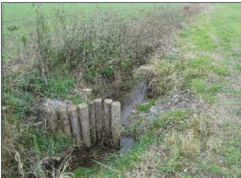
Abb 2.: Einbringen von Pfahlbuhnen, Foto: A.Woll,
