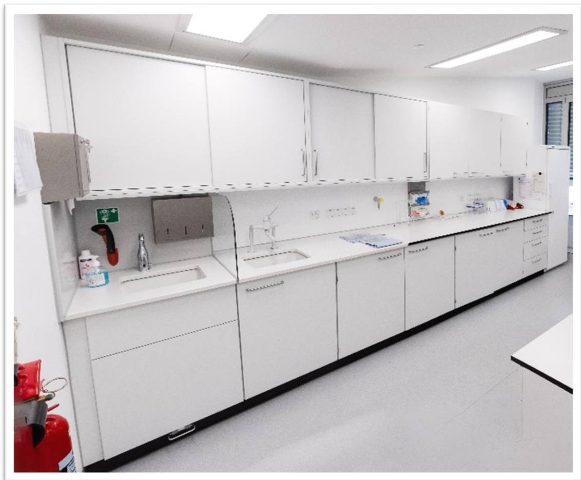
Abbildung 6: Laborzeile mit abgetrenntem Handwaschplatz; die kontaktlosen Spender sind in das Edelstahlgehäuse integriert
