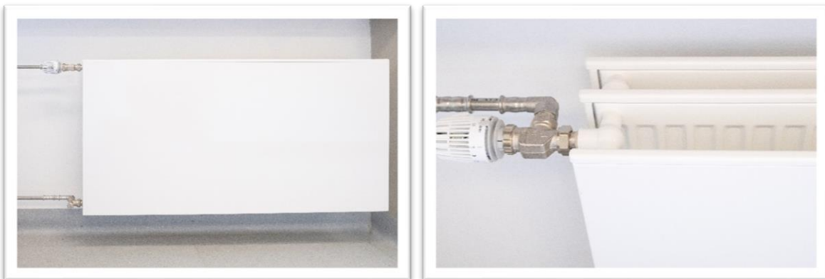
Abbildung 4: Heizkörper mit geschlossener Frontseite und gut erreichbaren Heizkörperzwischenräumen
