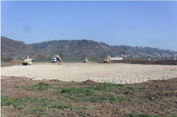
Bodenverbesserung für das Brückenbauwerk 9.1 am Anschlussknoten Weilheim
