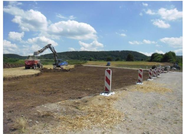
Baubeginn Oberbodenabtrag für das Brückenbauwerk 2.1 am Anschlussknoten Rottenburg/Ost
