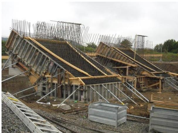
Brückenbauwerk 2.1 am Anschlussknoten Rottenburg/Ost, Schalung und Bewehrung Widerlagerfundamente
