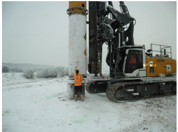
Brückenbauwerk 6.1 am Anschluss Buhl-Bonlanden, Herstellung Bohrpfähle
