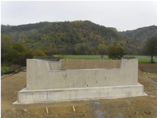
Brückenbauwerk 9.1 am Anschlussknoten Weilheim, Widerlager Nord (Blickrichtung Hirschau)
