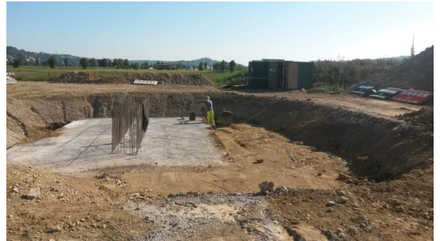
Brückenbauwerk 9.1 am Anschlussknoten Weilheim, Fundament Widerlager Nord betoniert
