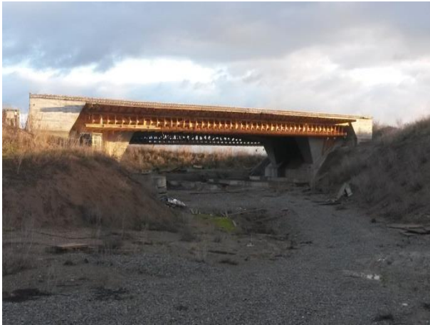
Brückenbauwerk 2.1 am Anschlussknoten Rottenburg/Ost, Seitenansicht (Blick Richtung Tübingen)
