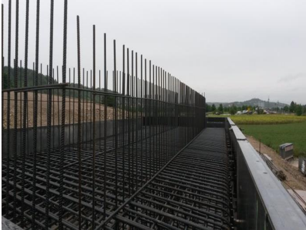
Brückenbauwerk 9.1 am Anschlussknoten Weilheim, Bewehrung Fundament Widerlager Nord
