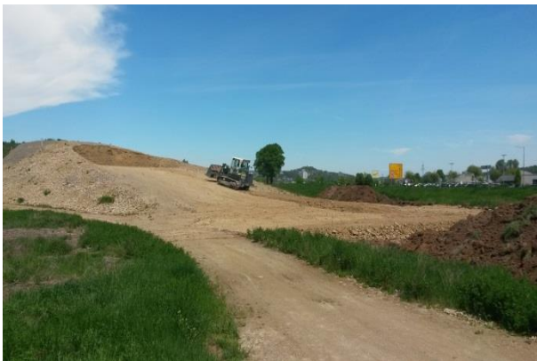
Herstellung der Gründungssohle für das Brückenbauwerk 9.1 am Anschlussknoten Weilheim
