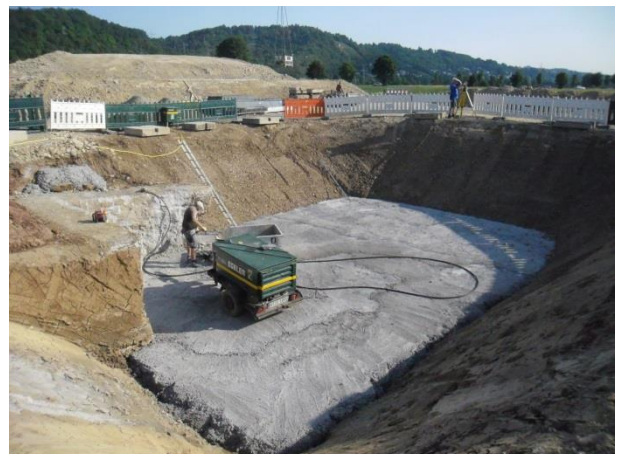
Brückenbauwerk 9.1 am Anschlussknoten Weilheim, Sauberkeitsschicht für das Fundament Nord
