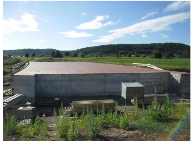
Brückenbauwerk 2.1 am Anschlussknoten Rottenburg/Ost, Fertiggestellter Brückenüberbau mit Beschichtung
