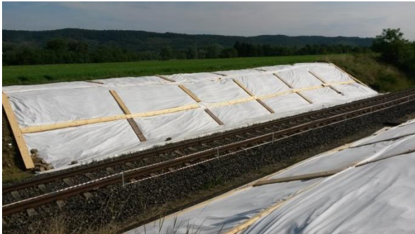
Brückenbauwerk 6.1 am Anschluss Bühl-Bonlanden, Vergrümpung von Zauneidechsen
