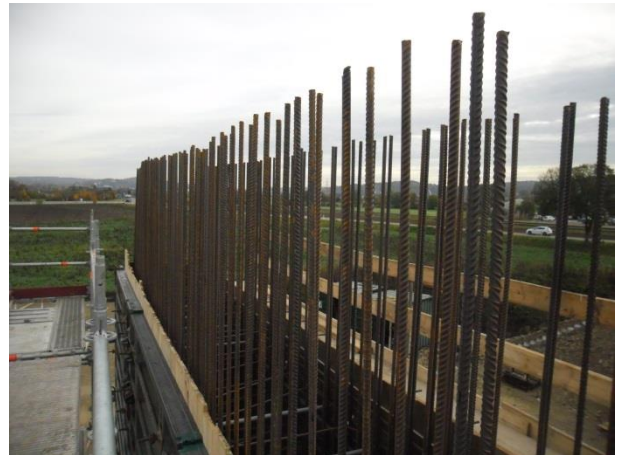
Brückenbauwerk 9.1 am Anschlussknoten Weilheim, Widerlager Mittelstütze zugeschalt
