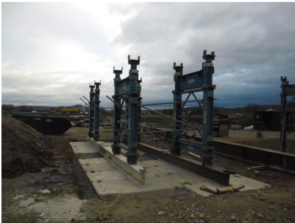
Brückenbauwerk 9.1 am Anschlussknoten Weilheim, Traggerüstfundament und Aufbau Traggerüst
