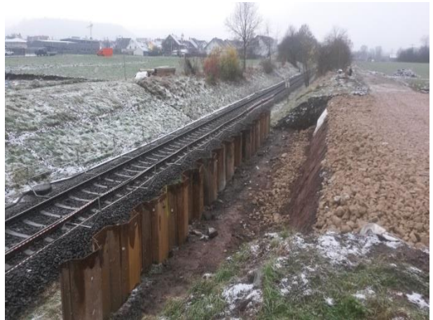
Brückenbauwerk 6.1 am Anschluss Buhl-Bonlanden, Herstellung Spundwand
