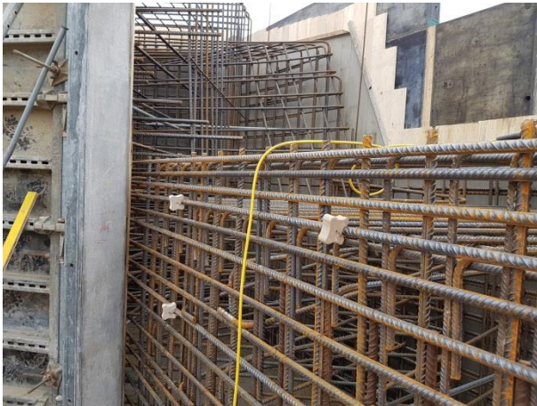
Brückenbauwerk 9.1 am Anschlussknoten Weilheim, Bewehrung Widerlager Süd
