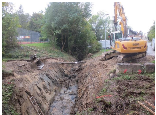
Ausbau des bestehenden Lindenbachdurchlasses in der Buckenwiese
