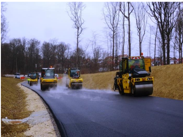
Herstellen der Asphaltdeckschicht in der Hauptachse der B 313 Ortsumgehung Grafenberg
