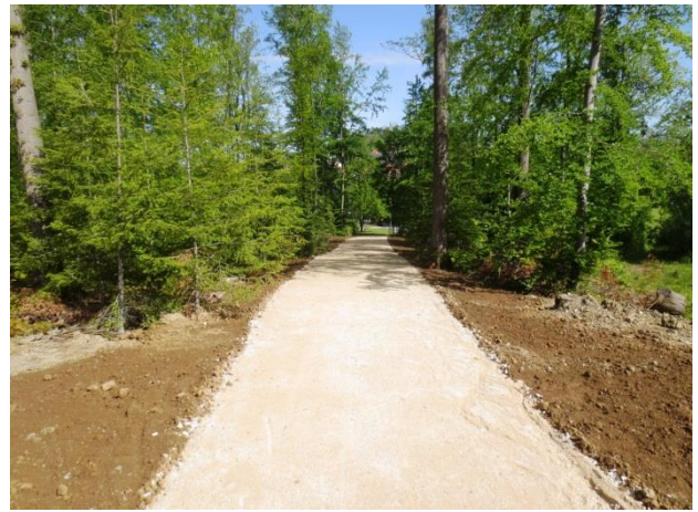
Fertiggestellter Fuß- und Wirtschaftsweg vor der Fußgängerüberführung BW 1
