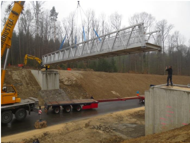
Einheben des Überbaus der Fußgängerüberführung BW 1 auf die Widerlager
