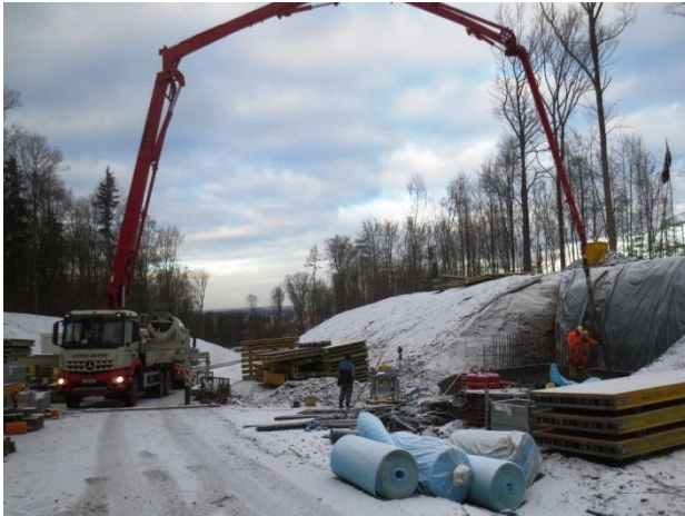
Betonieren des Fundaments für das Widerlager Nord der Fußgängerüberführung BW 1
