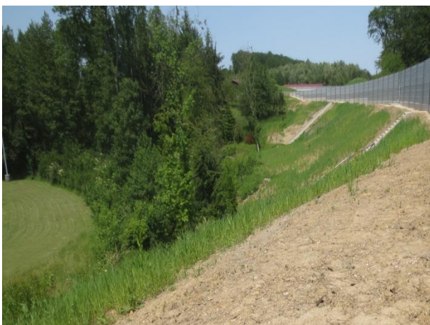
Abschließende Begrünung der B 313 Ortsumgehung Grafenberg
