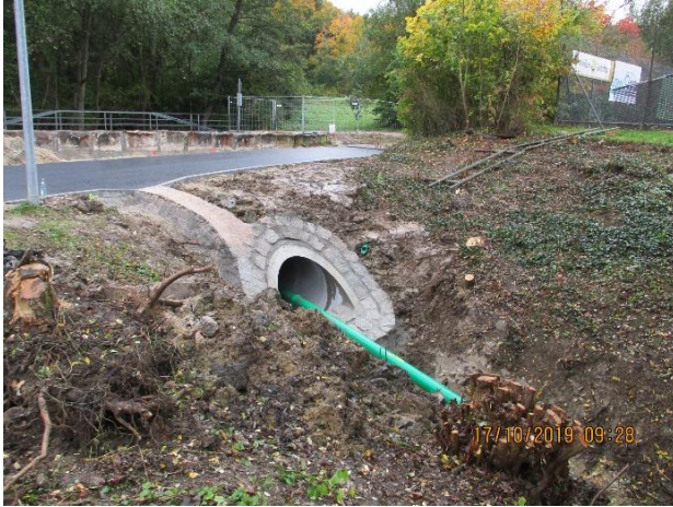
Abschließende Arbeiten an der Erweiterung des Lindenbachdurchlasses in der Buckenwiese
