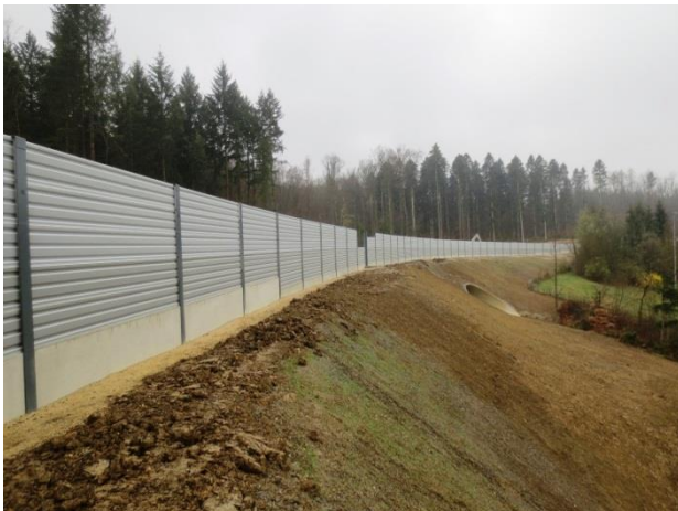
Neu erstellte Lärmschutzwand der B 313 Ortsumgehung Grafenberg Unterführung Bauwerk 5
