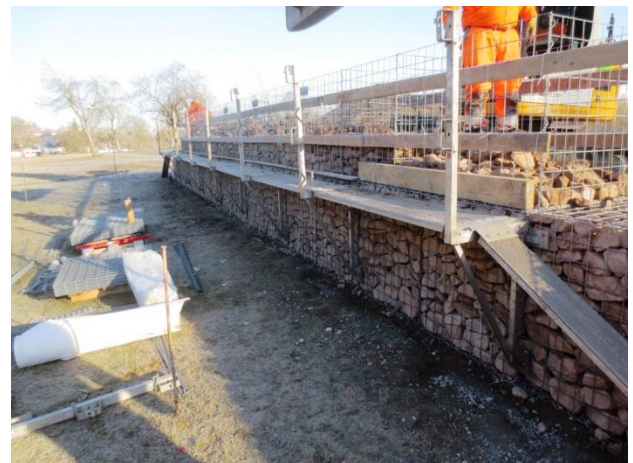
Herstellen und Befüllen der Gabionenwand
