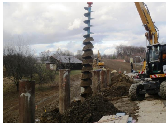
Herstellen der Bohrpfähle für die Lärmschutzwand
