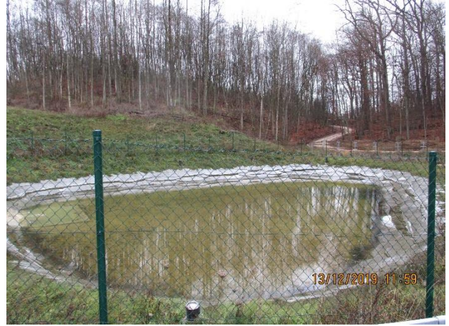
Funktionsüberprüfung der Regenrückhaltebecken der B 313 Ortsumgehung Grafenberg
