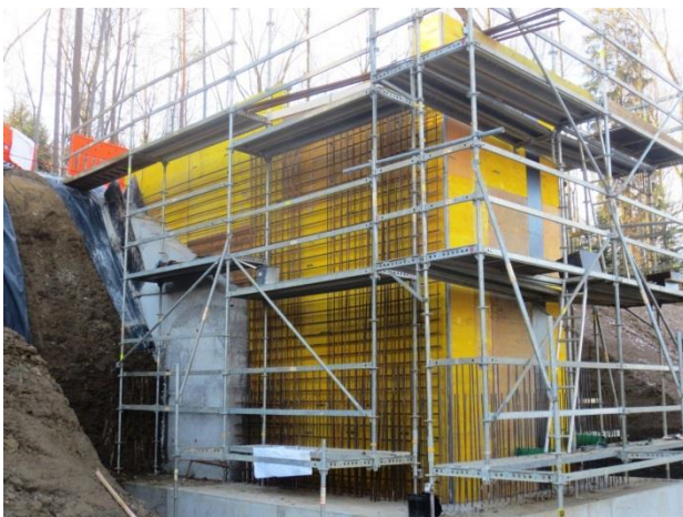
Bewehrungsarbeiten am Widerlager Süd der Fußgängerüberführung BW 1
