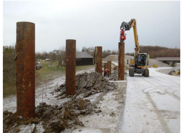
Einbringen der Verrohrung der Bohrpfähle für die Lärmschutzwand
