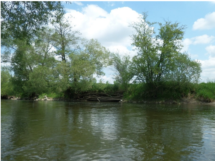
Abb. 6: Blick auf das rechte Donauufer mit Stangenverbau und Steinschüttungen
