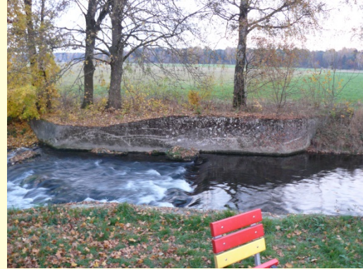
Sohlabsturz Schemmerhofen vor dem Umbau
