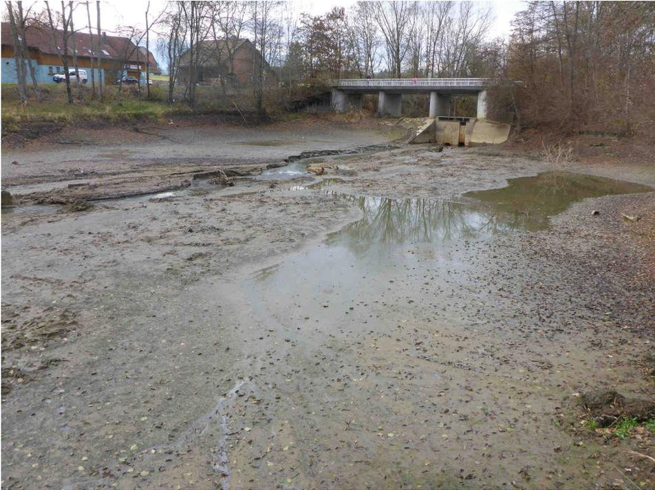
Abbildung 1 Sedimentablagerung im abgestauten Vorsee
