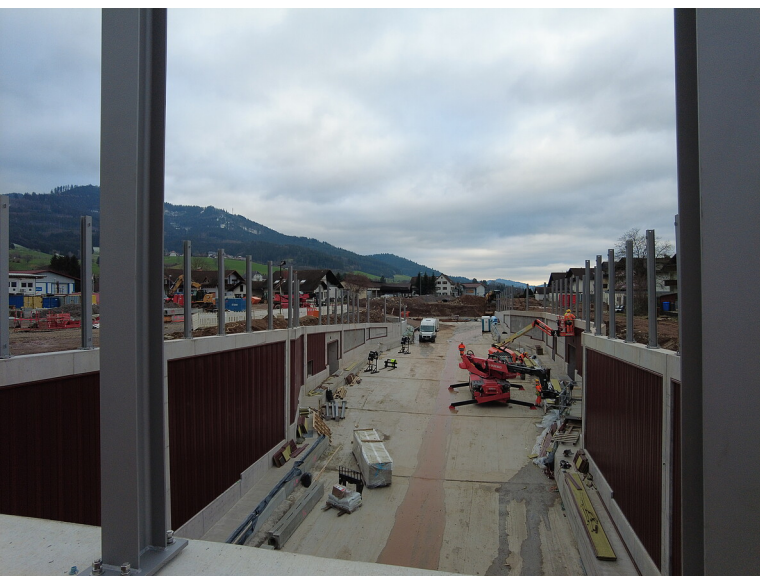
Blick auf das Tunnelportal Ost
