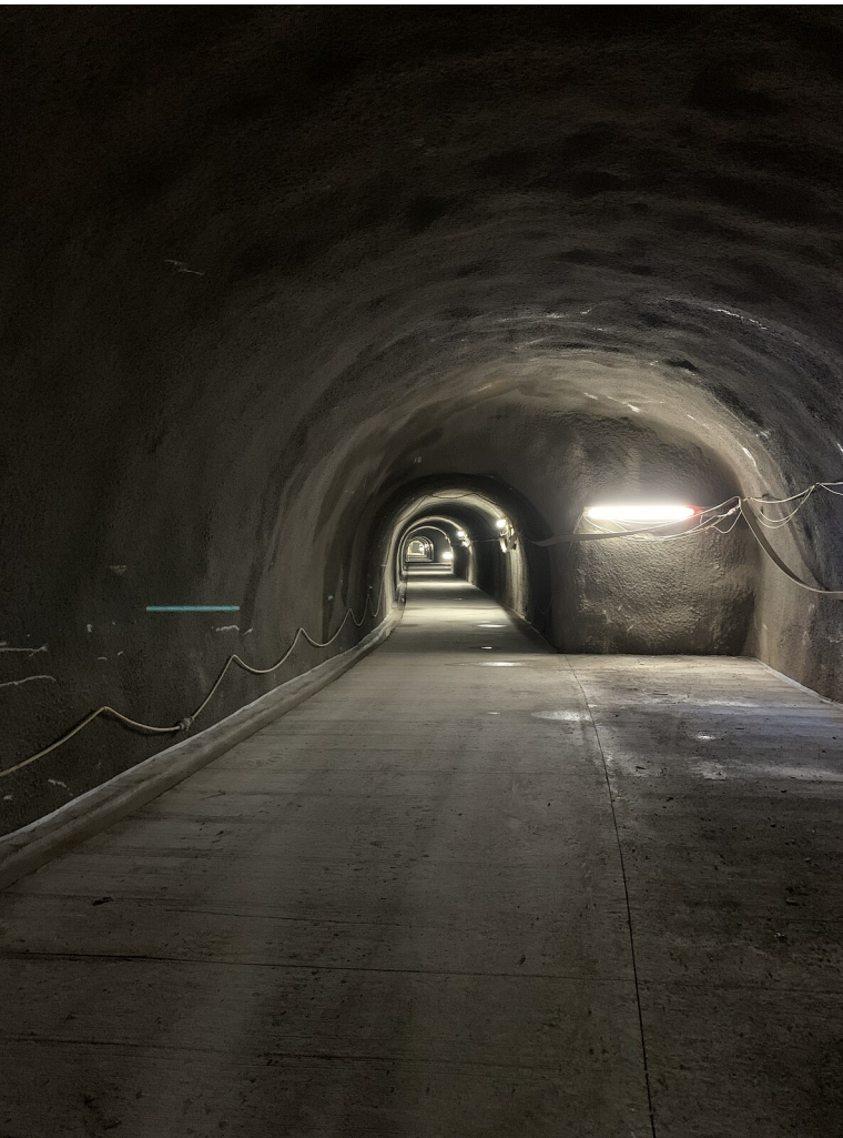
Der Rettungsstollen im Juni 2024
