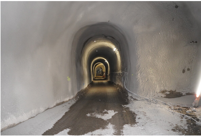
Der Rettungsstollen mit Spritzbeton ausgekleidet
