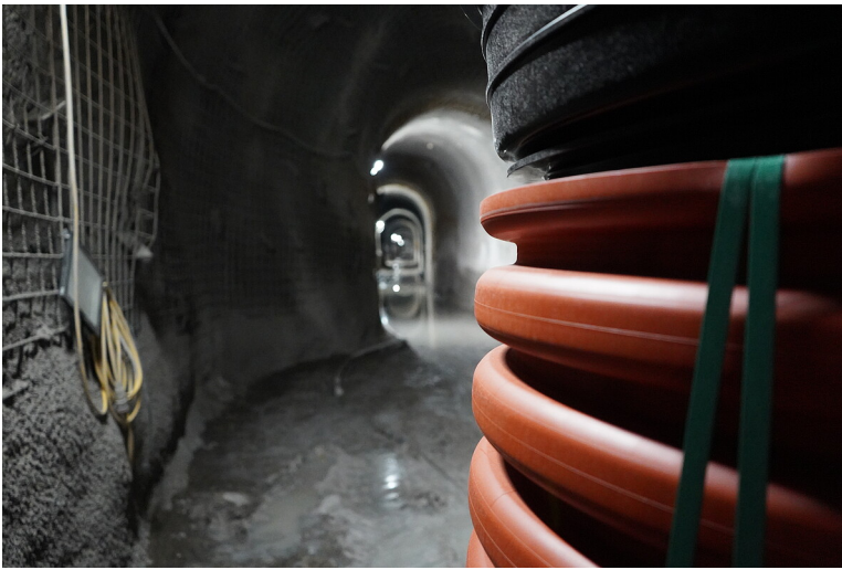
Blick in den Rettungsstollen
