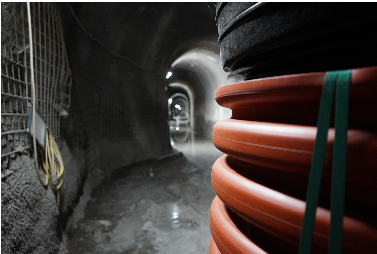
Blick in den Rettungsstollen
