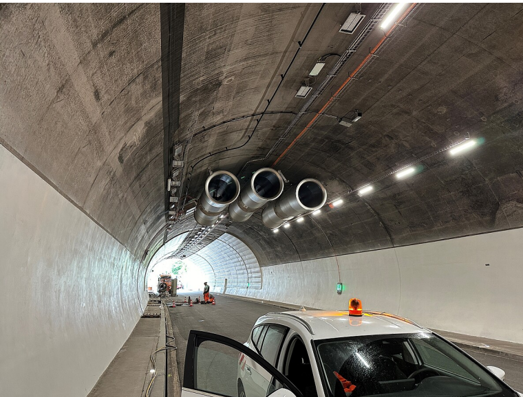
Neue Strahlenventilatoren und Beleuchtung im Sommerbergtunnel
