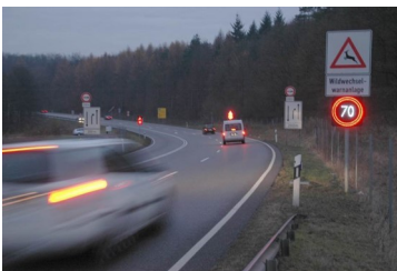
Wildwechselwarnanlage. Foto: FVA, Strein
