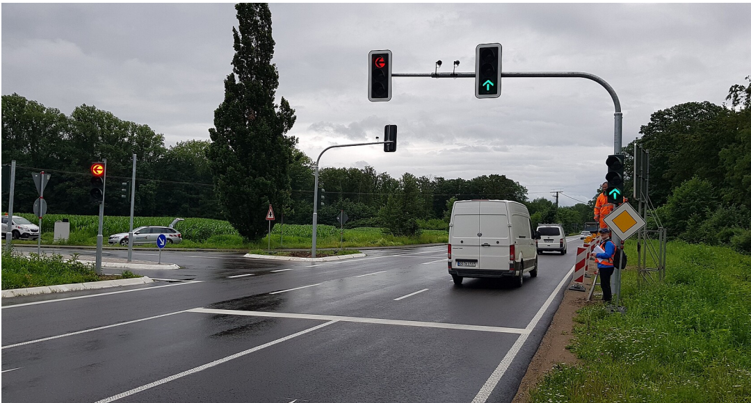
Kreuzung an der L 98 bei Kehl-Hohnhurst mit neuer Ampelanlage
