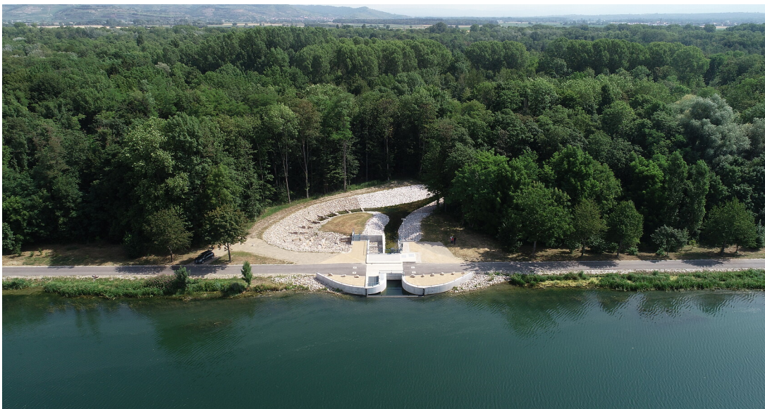
Einlassbauwerk mit Fischpass (Juli 2019)
