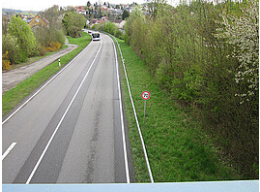
B 292 bei Waibstadt heute (Blick von der Adersbacher Straße zur Loßstraße)
