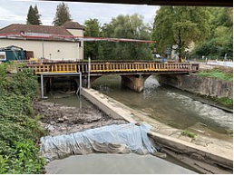
Abgedammter Triebwerkskanal
