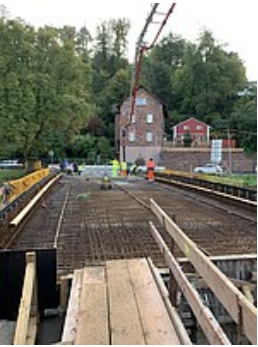
Betonage Überbau
