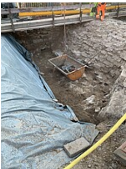
Aushub per Hand
