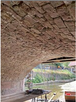
Bogenunterseite Fugenvorbereitung
