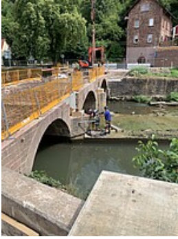
Aufbau Traggerüst Gründung Brückenfeiler
