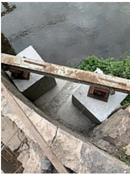
Aufbau Traggerüst Gründung Böschungsbereich
