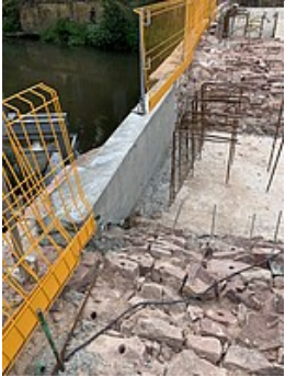
Betonierte Fehlstelle im Mauerwerk
