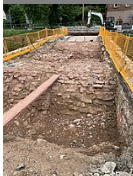
Teilweise leergeräumte Brückenbögen
