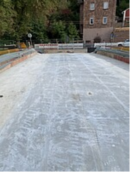
Betonierter Überbau
