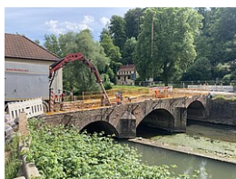
Freilegen der Brückenbögen mit Saugbagger
