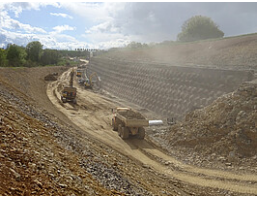
BA V - Erdarbeiten und Hangsicherung
