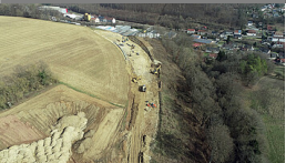
BA V - Luftbild Erdarbeiten
