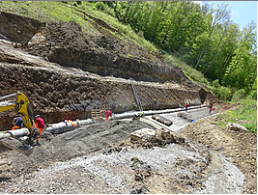
BA V - Vorbereitungsarbeiten Durchlassbauwerk Kandelbergklinge
