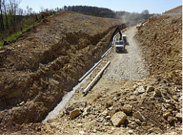
BA V - Umverlegung Fernwasserleitung
