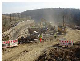
BA V - Hangsicherung mit Spritzbeton
