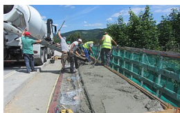
Weschnitzbrücke - Betonage der Kappen
