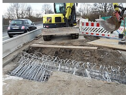
Weschnitzbrücke - Ausgebauter Fahrbahnübergang
