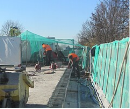
Weschnitzbrücke - Vorbereitung Kragarm und Anschlussbewehrung für den Bau der Kappen
