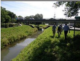
Bereich Hebewerk N des AHW und B 3-Brücke - Blick gegen Fließrichtung
