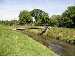
Fußgängersteg bei den Kleingärten - Blick in Fließrichtung
