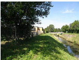
Bereich Hebewerk N des AHW - Blick in Fließrichtung
