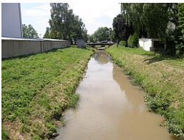
Fußgängerbrücke oberhalb Leimbach-Pegel - Blick in Fließrichtung
