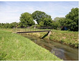
Fußgängersteg bei den Kleingärten - Blick in Fließrichtung
