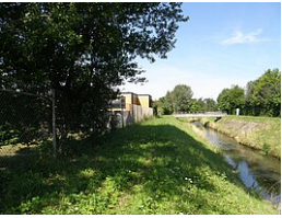
Bereich Hebewerk N des AHW - Blick in Fließrichtung
