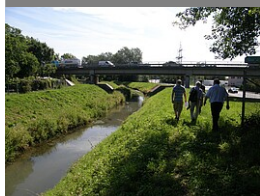
Bereich Hebewerk N des AHW und B 3-Brücke - Blick gegen Fließrichtung
