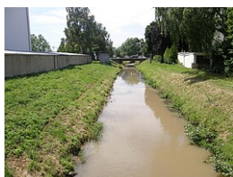
Fußgängerbrücke oberhalb Leimbach-Pegel - Blick in Fließrichtung
