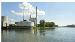
RHWD XXV RDK - Blick vom nördlichen Hafeneingang nach Süden zum RDK
