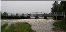
Hochwasserentlastungsanlage mit drei Klappen in Betrieb beim Hochwasser Juni 2013
