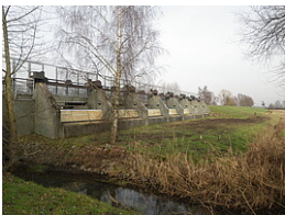
Ansicht von Westen auf die Hochwasserentlastungsanlage
