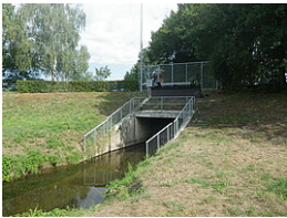
Ansicht von Süden auf das Grundablassbauwerk am Sulzbach
