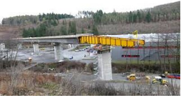
Taktschieben Seckachtalbrücke im Zeitraffer
