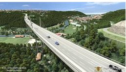
B 32, Ortsumfahrung Horb (Neckartalviadukt) (Planungsstand 2018)
