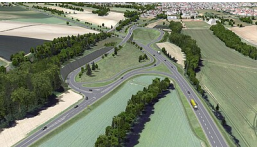
Trassenfahrt Ortsumgehung Jöhlingen
