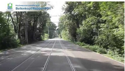
Bellenkopf-Rappenwörth: Höherlegung Hermann-Schneider-Allee
