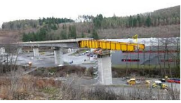
Taktschieben Seckachtalbrücke im Zeitraffer
