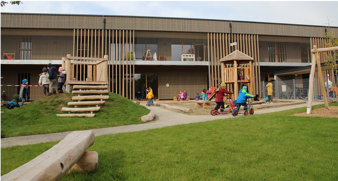
Neubau Kindergarten Markdorf Süd
