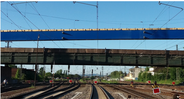
Einhub neue Stahlträger
