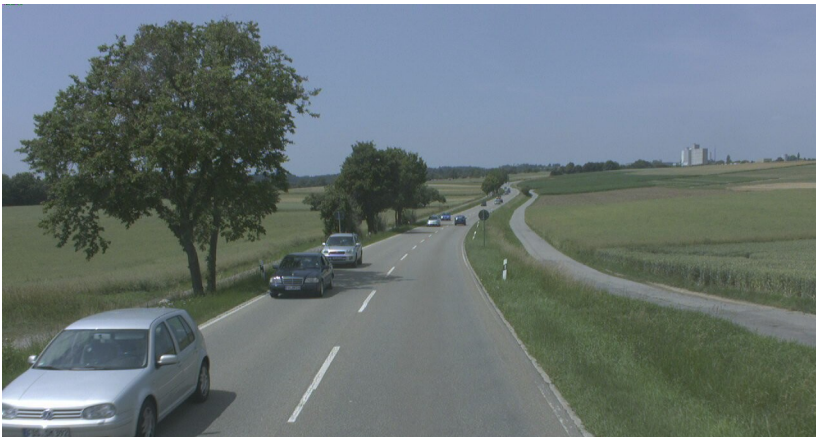
Routinemäßige Befahrung des Betriebsdienstes auf der L 355b in Richtung Westen
