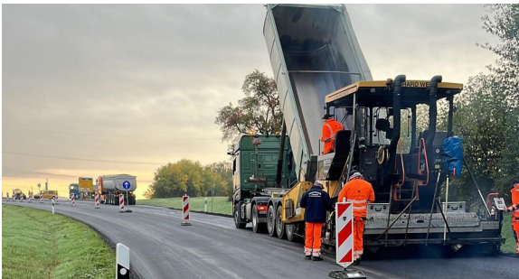
Halbseitiger Asphalteinbau am Knotenpunkt
