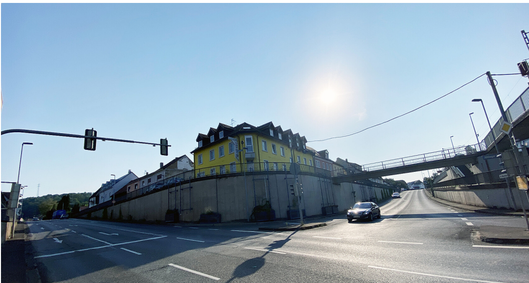
Grundwasserwanne in Berghausen
