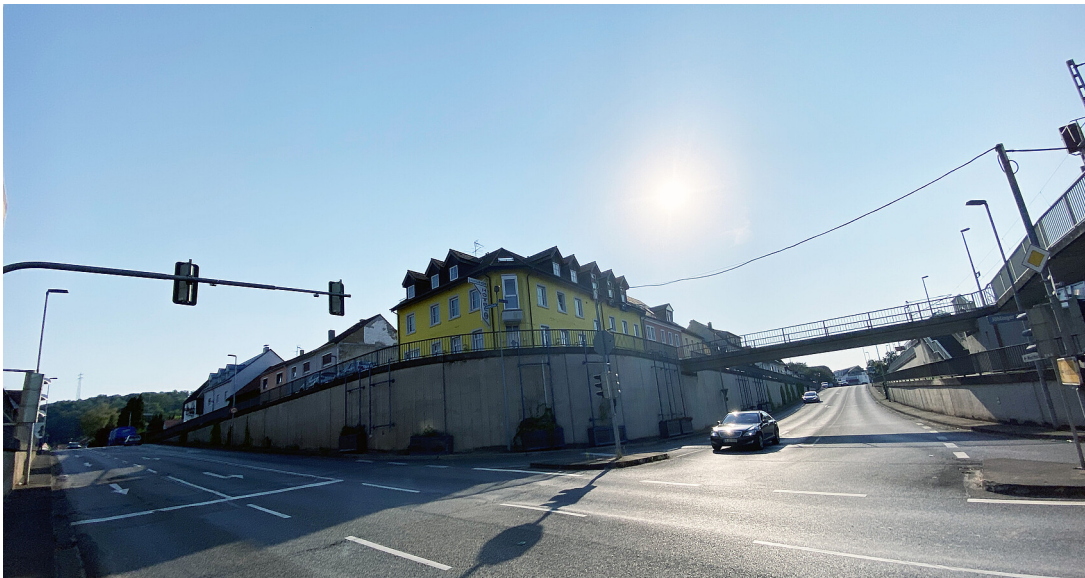
Grundwasserwanne in Berghausen
