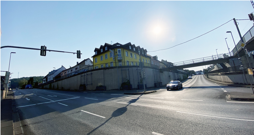
Grundwasserwanne in Berghausen
