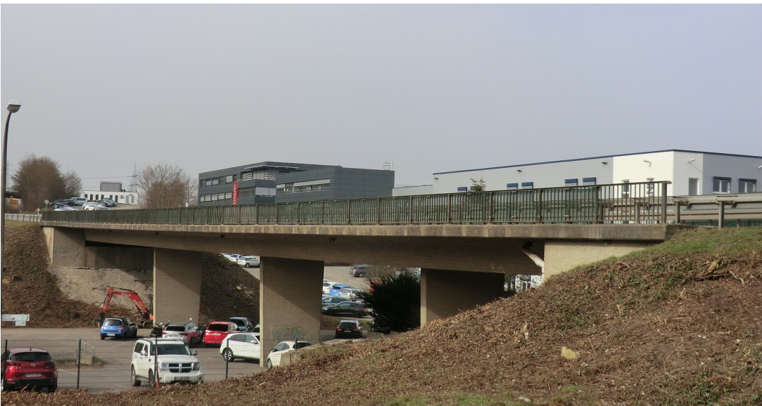
Bestehende Kieselmannbrücke über die K 4520 bei Knittlingen
