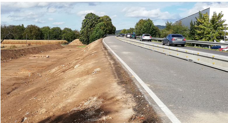
Zustand vor Dammverbreiterung
