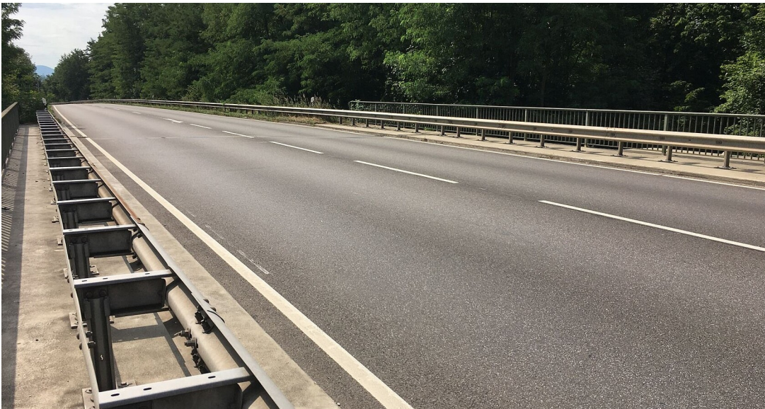
B 462, Ostblick von Rastatt Richtung Autobahn
