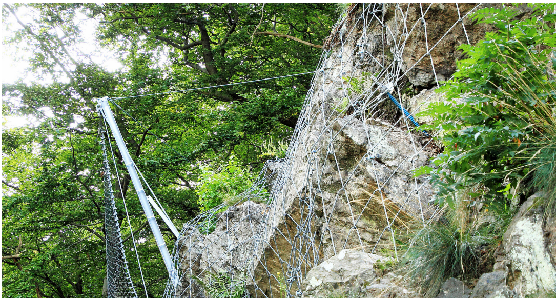
Symbolbild "Felssicherung am Hang mit Drahtnetz"
