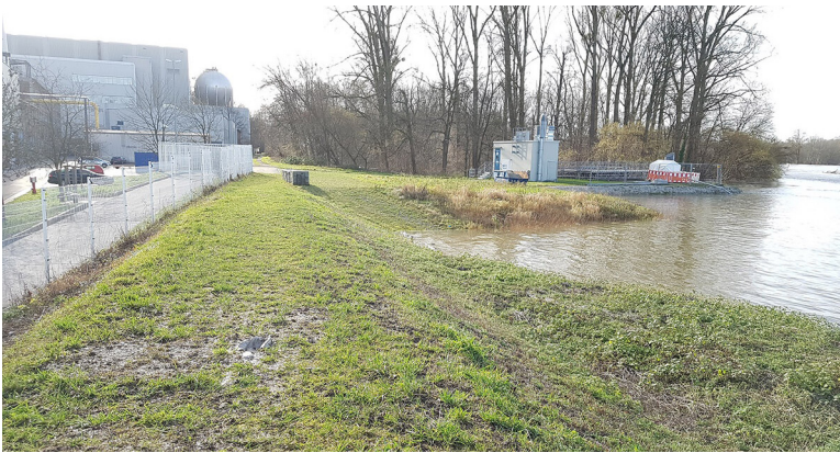
Der Rheinhochwasserdamm XXV am Rheinhafen-Dampfkraftwerk beim Hochwasser 2018
