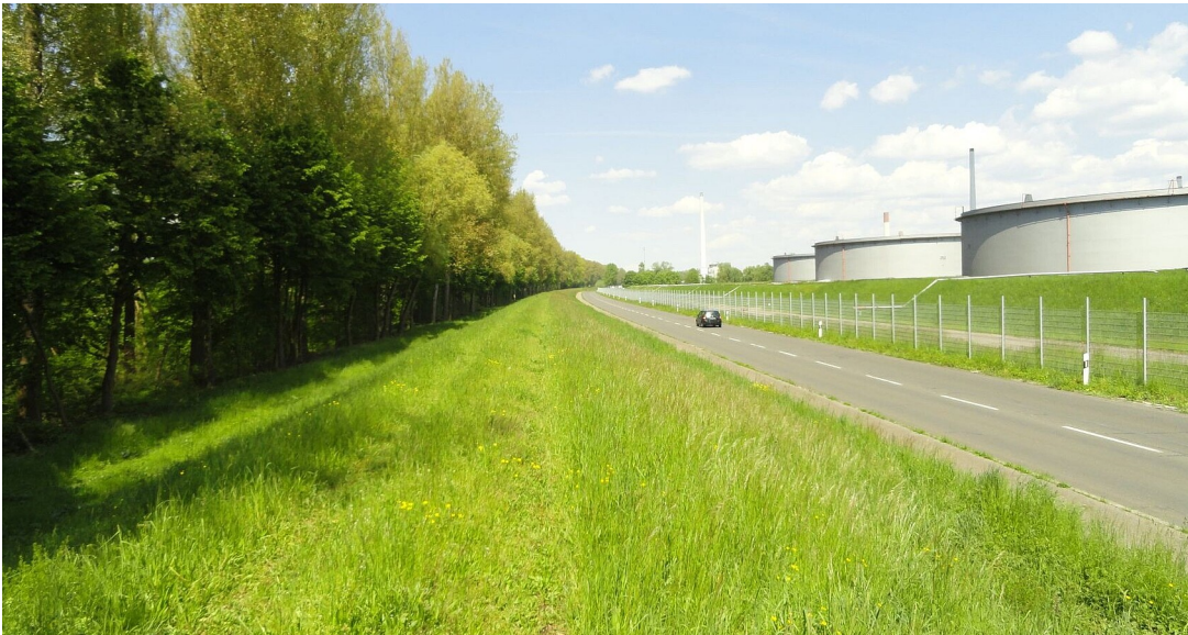
Der Rheinhochwasserdamm XXVII entlang der MiRO
