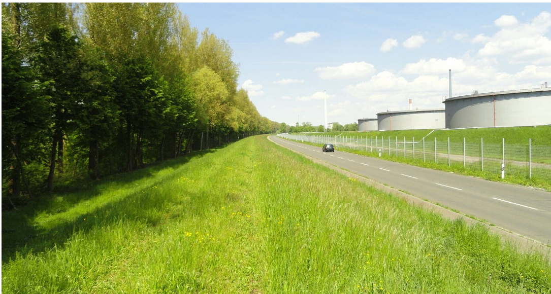
Der Rheinhochwasserdamm XXVII entlang der MiRO
