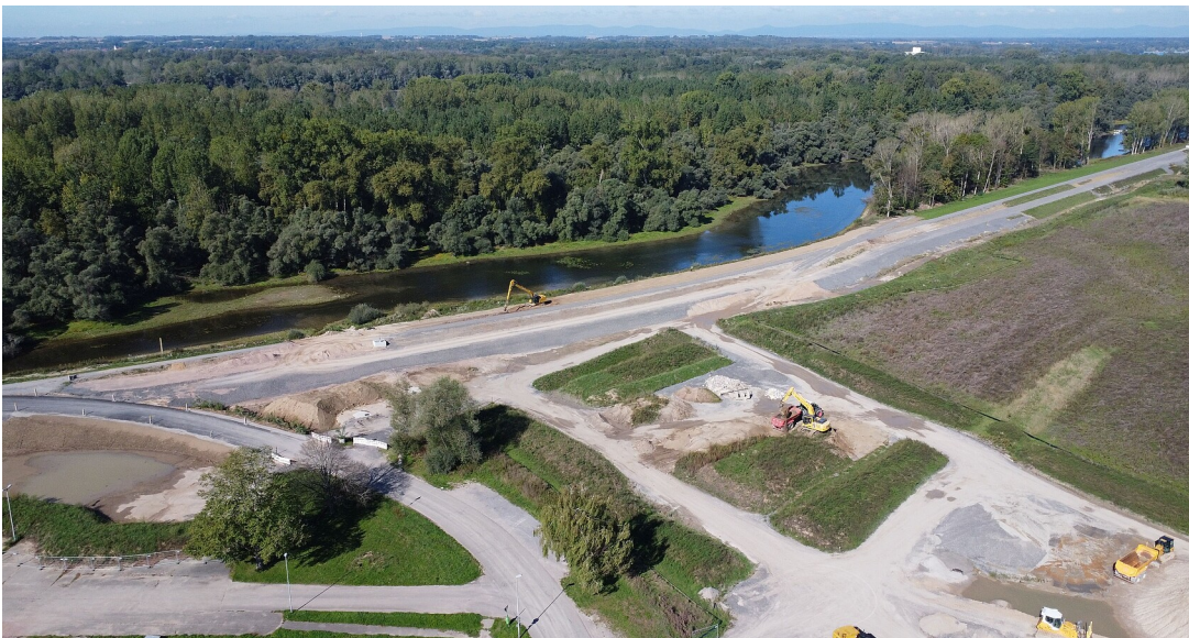
Aktuelle Dammbauarbeiten im Baulos 5 im Bereich der Dammüberfahrt am Sportplatz Elchesheim-Illingen
