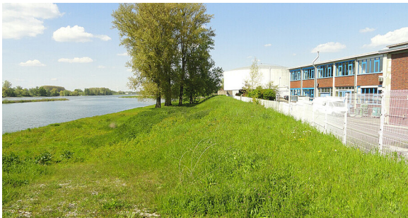
Der Rheinhochwasserdamm XXV am Rheinhafen-Dampfkraftwerk
