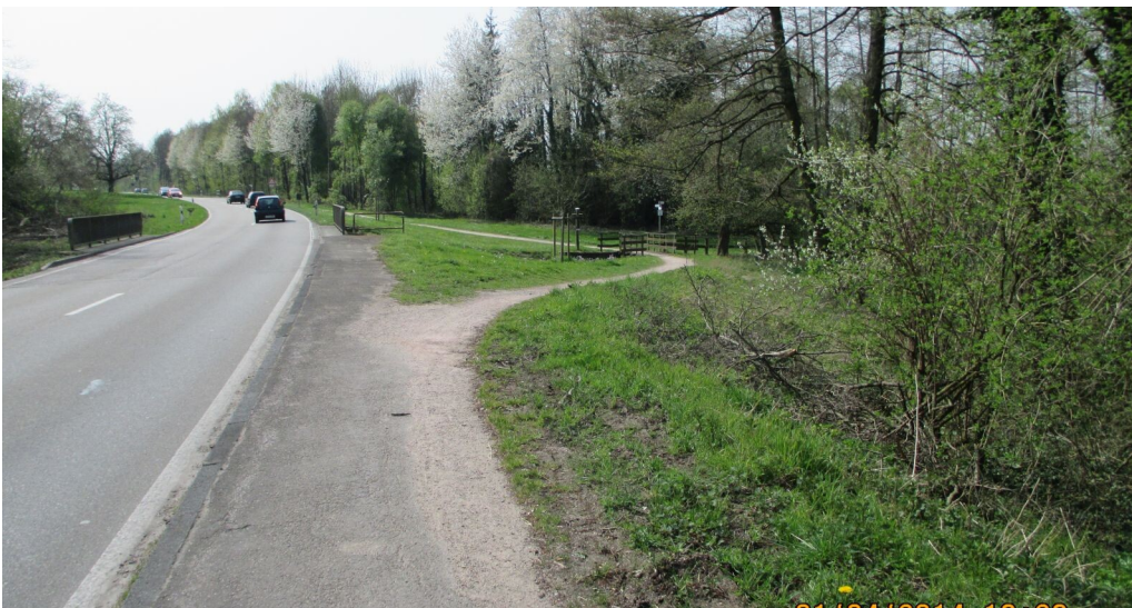
Landesstraße L 67 etwa 200 m nach Ortsausgang Kuppenheim Fahrtrichtung Haueneberstein
