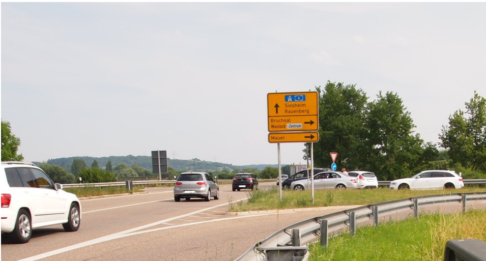
Anschluss der L 594 (Südtangente Wiesloch, Südwest-Rampe) an die L 723, Blickrichtung zur A 6
