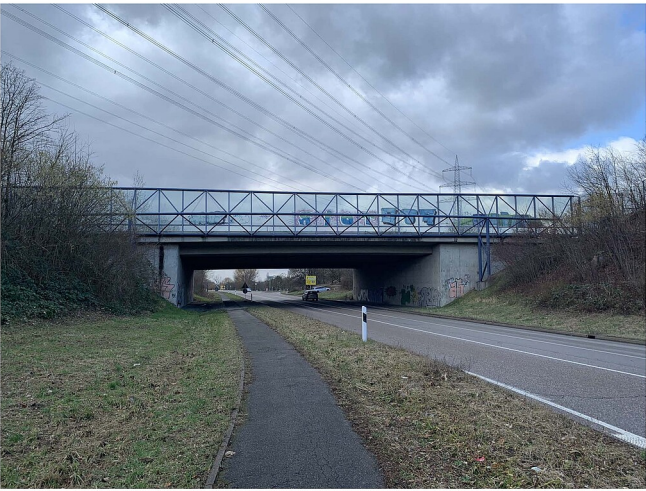
Bauwerk-Bestand Ansicht Ost (Teilbauwerk 1) mit vorgesetzter Lärmschutzwand
