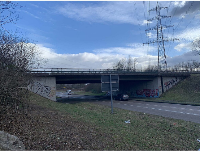
Bauwerk-Bestand Ansicht West (Teilbauwerk 2)
