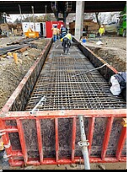
Herstellung Bewehrung Fundament
