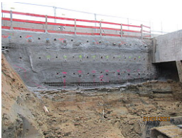
Herstellung Spritzbetonwand
